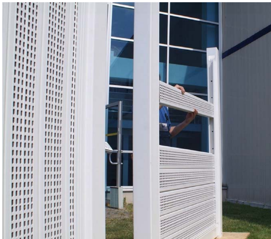
Rys. 5 Montaż paneli akustycznych jeden na drugim.
