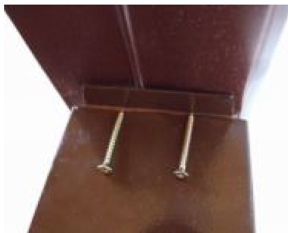
Montaż dolnej części poręczy do słupka
