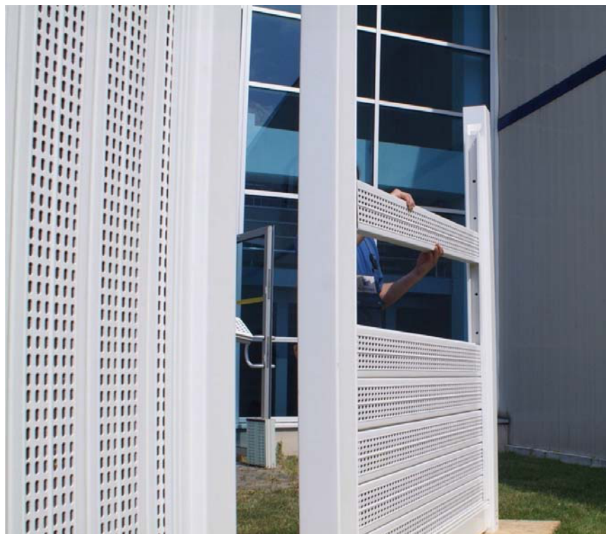
Rys. 5 Montaż paneli akustycznych jeden na drugim.
