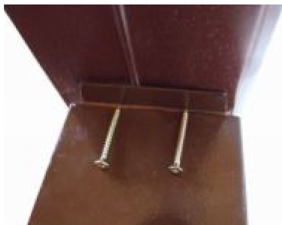
Montaż dolnej części poręczy do słupka
