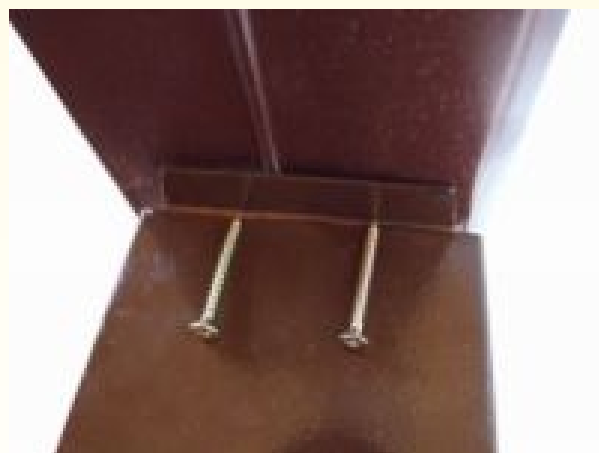
Montaż dolnej części poręczy do słupka
