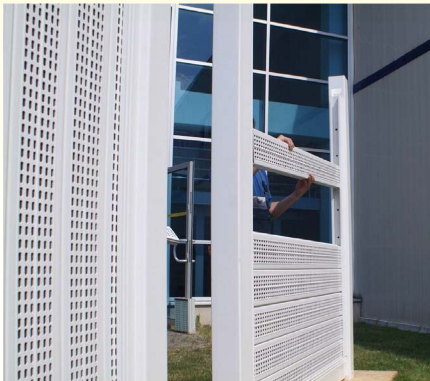
Rys. 5 Montaż paneli akustycznych jeden na drugim.
