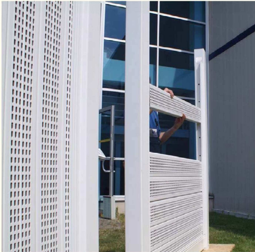
Rys. 5 Montaż paneli akustycznych jeden na drugim.
